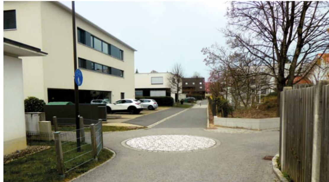
Abb 23 Beispiel eines Mosaiks als Markierung im Kreuzungsbereich
